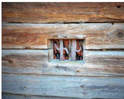
Drewniany spichlerz o konstrukcji zrębowej, wybudowany w 1869 r. Obecnie pełni funkcje lamusa. Fot. Katarzyna Kot
