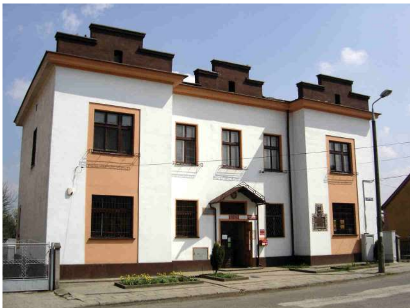
Budynek grodzki z wmurowaną tablicą poświęconą królowi Kazimierzowi Wielkiemu. Fot. Dariusz Kobylański
