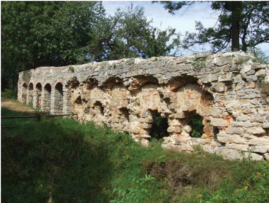
Pozostałości muru strzelniczego (odrestaurowane). Fot. Marcin Szala
