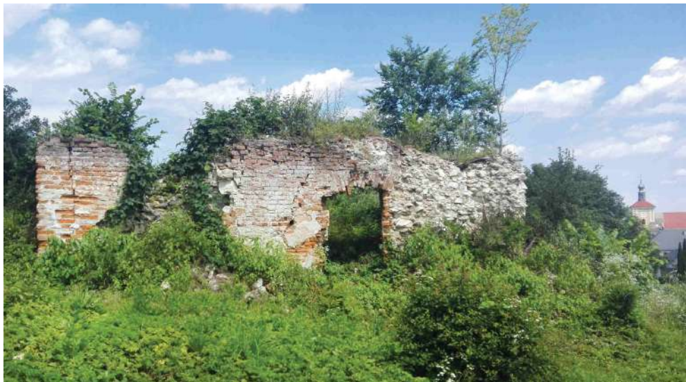
Pozostałości wieży zamkowej. Fot. Radomir Wilkowski (WP)
