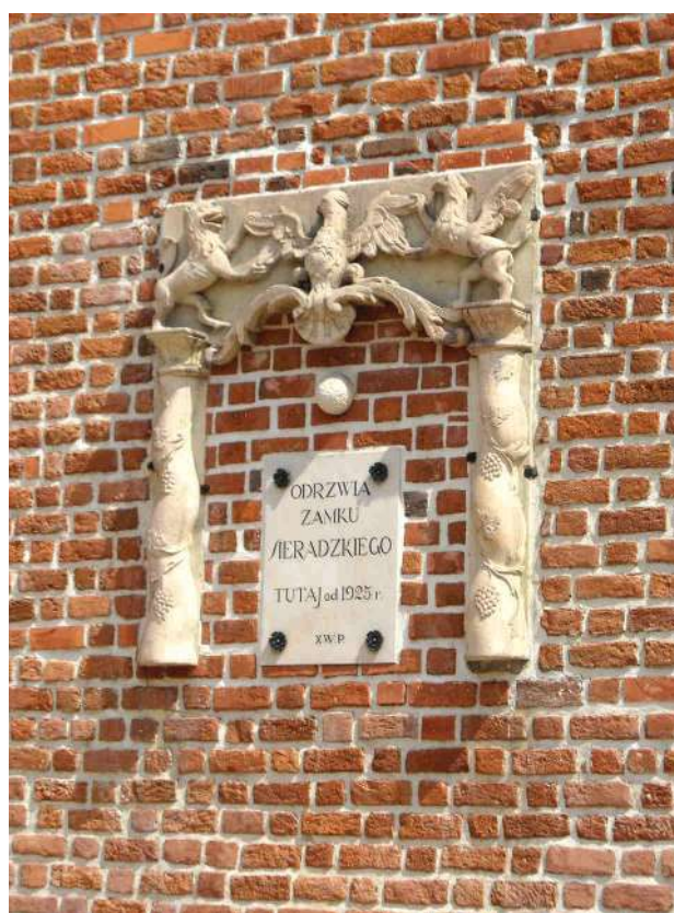
Odrzwia zamku sieradzkiego wmurowane w zewnętrzną ścianę kościoła pw. Wszystkich Świętych. Fot. Pabis (WP)
