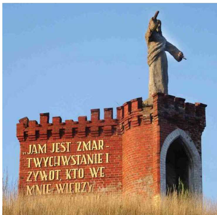
Prochownia z 1891 r. z figurą Chrystusa na cmentarnym wzniesieniu. Fot. Pit1233 (WP)
