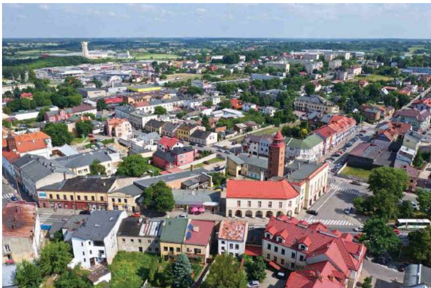
Centrum Rawy Mazowieckiej z wieżą strażacką.
