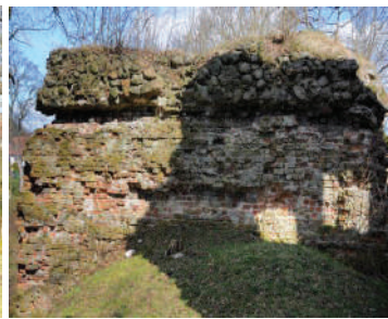
Pozostałości cokołu masywnego, narożnego, kamienno-ceglanego bergfriedu w Dobrej. Fot. Piotr A. Zaniewski
