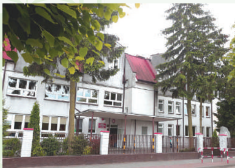
Budynek Szkoły Podstawowej im. Marii Skłodowskiej-Curie w Przyjmie. Fot. Archiw. SP w Przyjmie
