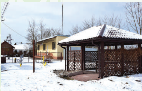
Świetlica wiejska w Szczytnikach
