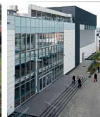
Obiekty sportowe UKW przy ul. Sportowej 2
