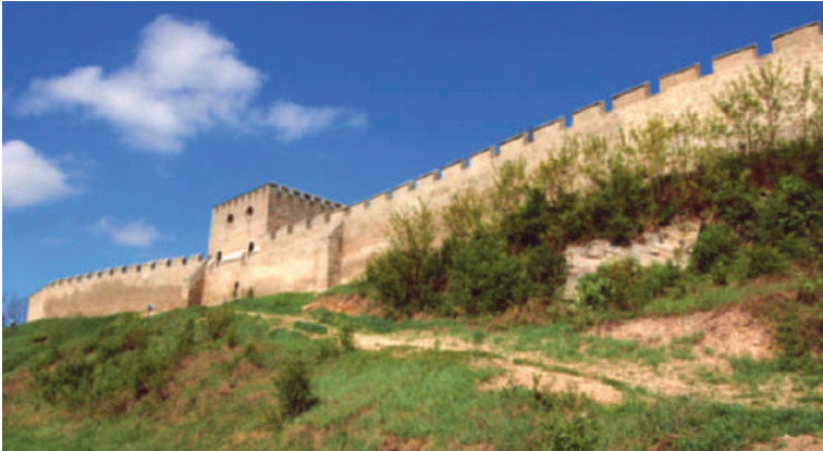
Mury obronne szydłowieckie- go zamku od zachodu 2 . Fot. P. Walczak
