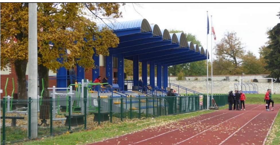
Kompleks obiektów sportowych w Stopnicy
