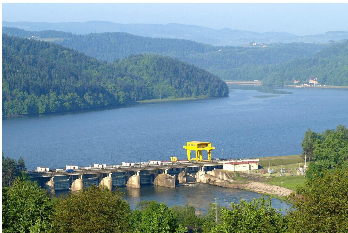
Zapora wodna z elektrownią na Dunajcu
